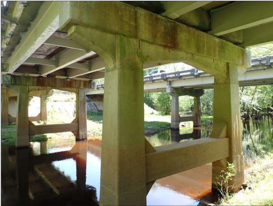
Bent 1 (Bent 2 and 3 Similar)
